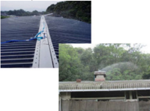
写真2 ホームセンターや園芸資材店で購入したスプリンクラーで設置
