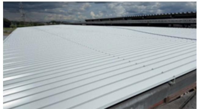
写真4 断熱塗料を塗った屋根
