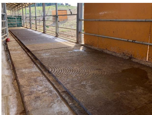
写真 5 寒冷対策（ゴムマットの設置）
