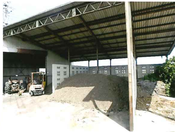
写真2 ストック用堆肥舎
