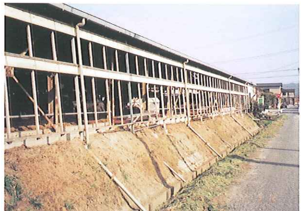
写真8：フリーバーン牛舎側面（M牧場）
