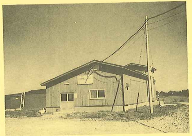
写真3：発酵舎 (内部に発電機及び一次発酵槽を備えている)
