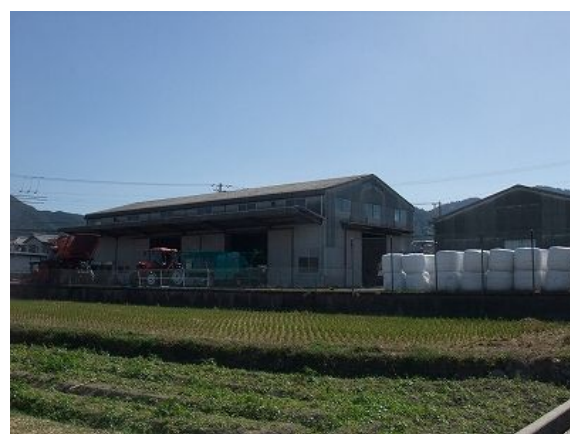
機械格納施設と製品保管場所
