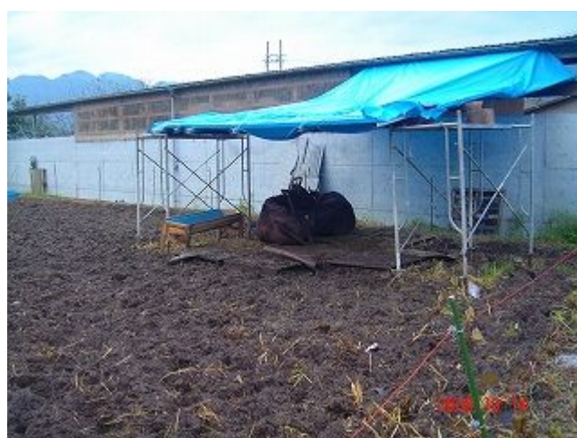
写真4 簡易休憩所を設置
