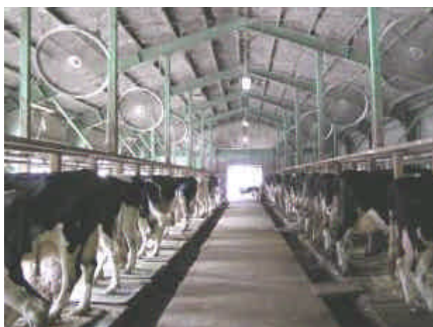
写真 1 横換気(引抜)から縦送風に改善した牧場
