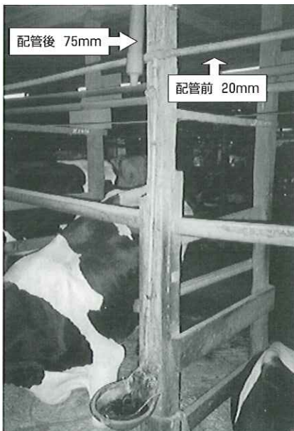
写真1 配管前後の管口径
