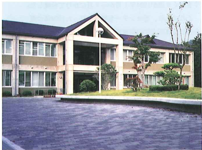
新築された兵庫県神戸農業改良普及センター庁舎 (写真提供：姫路家畜保健衛生所神戸分室)
