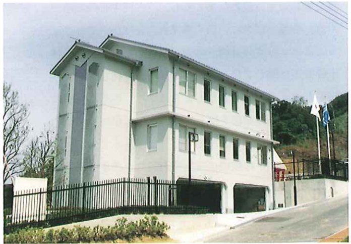
新築された淡路食肉衛生検査所
