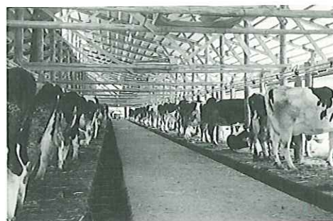
完成した80頭牛舎
