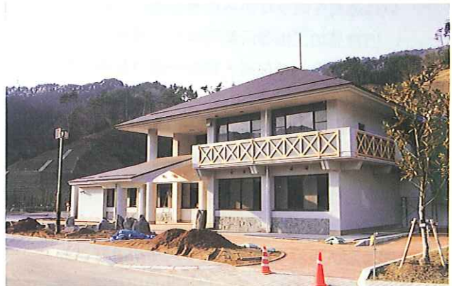
兵庫県立北部農業技術センター 加工流通棟
