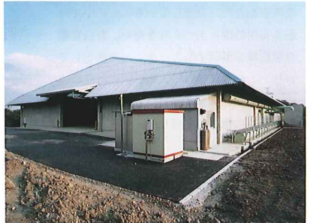
神戸市大型堆肥発酵施設 (神戸市西区) 〔写真提供: 神戸市農政局生産振興課〕
