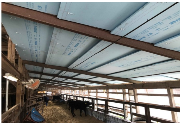
写真2 屋根裏に断熱材設置事例
