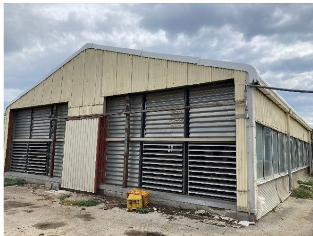
写真 1 排気ファンの設置
