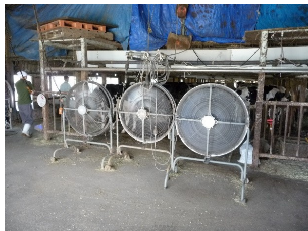
写真 2 吸気口側に設置した送風機
