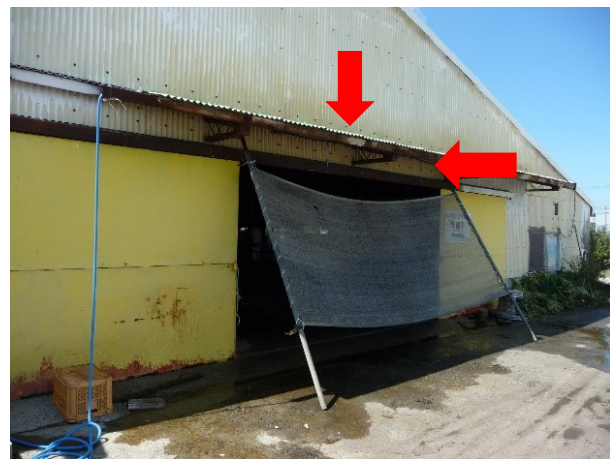
写真 3 吸気口側でネットへの散水 (矢印は散水位置)
