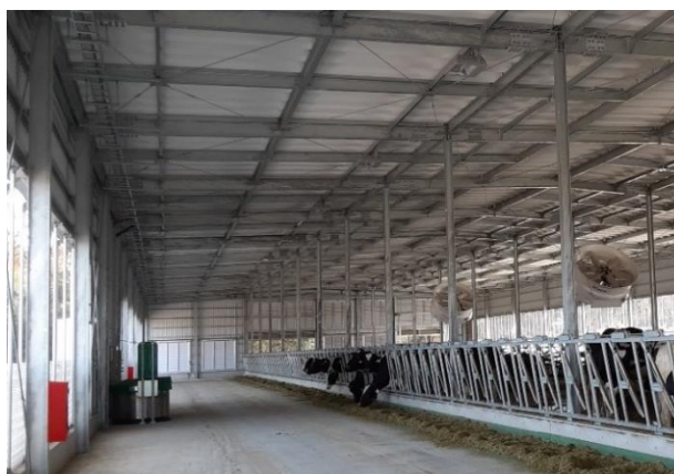
写真 1 新設した牛舎
