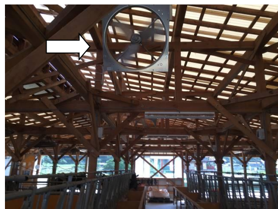
写真 3 新送風機設置状況
