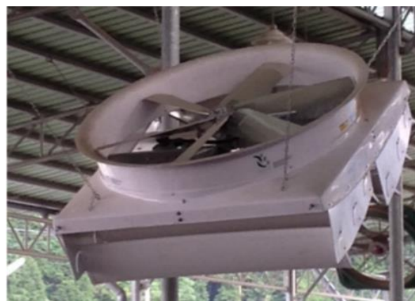
写真 4 1m 径送風扇の 7 台分の能力を有する大型送風扇
