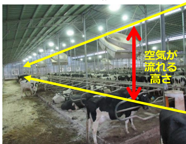
写真 6 トンネル換気導入後の牛舎内部
