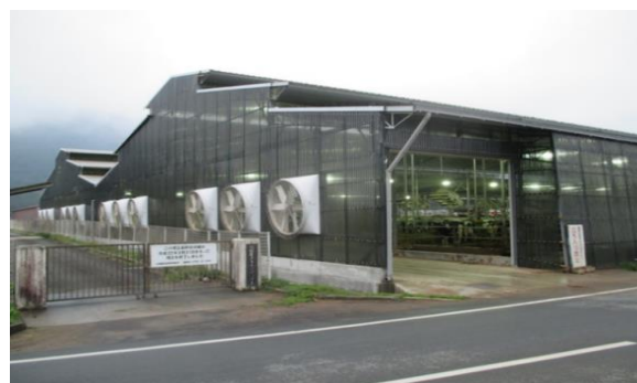
写真3 排気側からの牛舎外観
