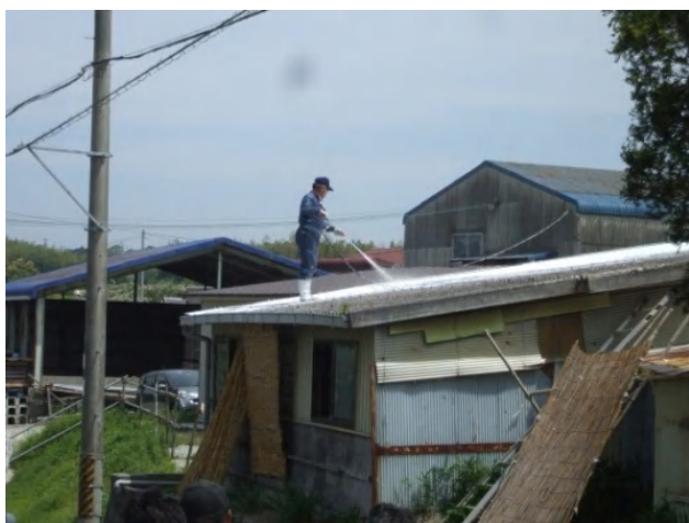
写真1 ドロマイト石灰乳塗布作業
