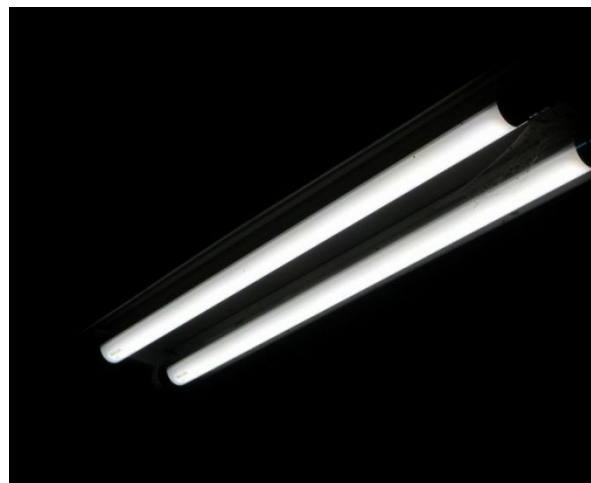
図14 常に清掃を実施しているLED蛍光灯
