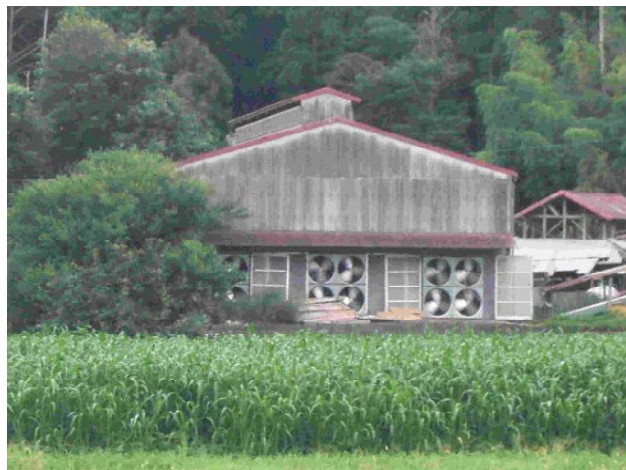
夏バテ防止で乳量アップ！ ～トンネル換気による暑熱対策～ (写真提供：姫路農業改良普及センター)
