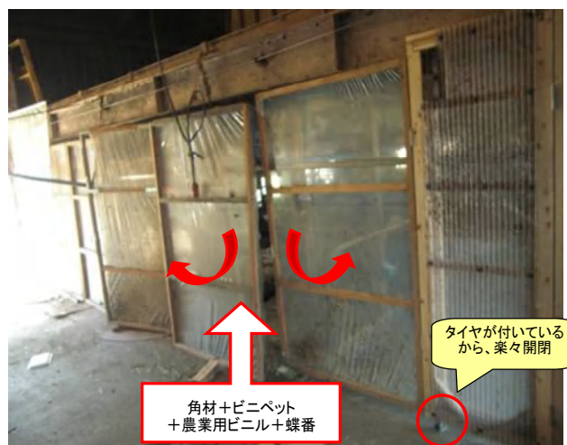
写真3 牛舎作業の邪魔にならないように簡単に開閉できるように工夫した
