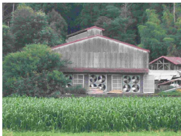
写真1 換気扇を14台設置した牛舎
